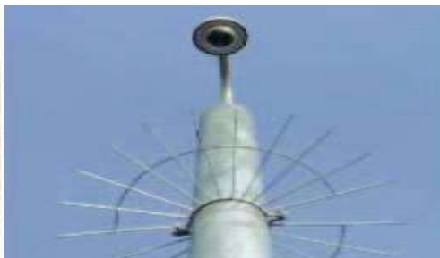
〈그림 2-43〉 CCTV 설치
