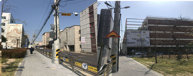
CCTV 및 LED 보안등 설치
