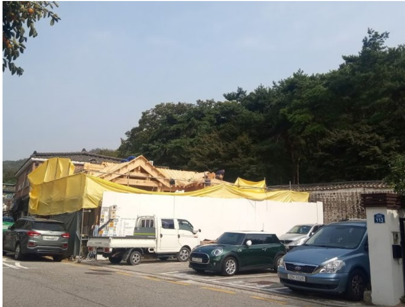
図-3-16 保護区域（A-3街区）における韓屋の新築
