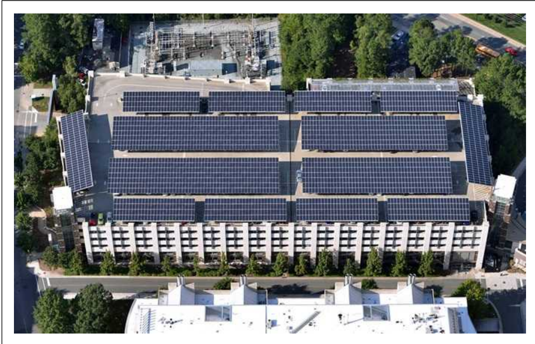
< 옥상 주차면 활용 태양광 발전설비 설치(듀크대) >
